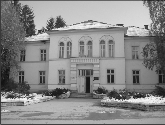
Zgrada SO Berane sada, nakon rekonstrukcije
